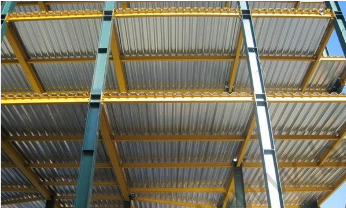
سقف عرشه فولادی بدون شمع بندی (تحمل وزن توسط تیر فولادی)
