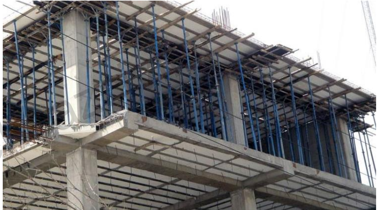
سقف تیرچه بلوک (بتنی) با شمع بندی (جک)
